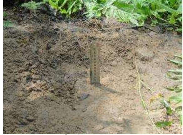
সিলটেশন গজ স্থাপন
